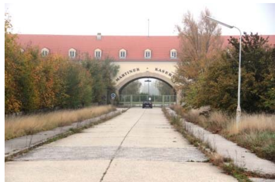
Abbildung 3: Eindrücke vom Areal der ehemaligen Martinek-Kaserne in Baden, Quelle: Markus Maxian
